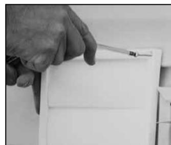
**3** Enfoncez la hotte dans l'ouverture. Fixez la hotte sur le mur extérieur en utilisant des vis de montage. Répétez la procédure d'installation pour la hotte d'aspiration et la hotte d'évacuation.
