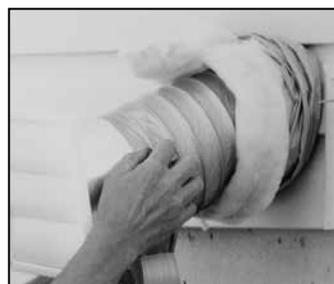
**2** Faites passer le conduit flexible isolé dans l'ouverture jusqu'à ce qu'il soit bien tendu et droit. Faites glisser le manchon en vinyle interne du conduit sur le collet avec l'isolation et placez le parevapeur sur le manchon. Fixez à l'aide de ruban adhésif en toile.
