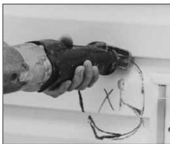
**1** Tracez le contour du collet de la hotte externe pour découper les trous d'aspiration et d'évacuation. Le diamètre des trous doit être un peu plus grand que celui du collet, pour tenir compte de l'épaisseur du conduit flexible isolé. Percez un trou pour la hotte d'aspiration et un trou pour la hotte d'échappement
