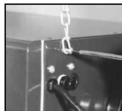
2. Suspendez la chaîne à chaque coins du VRC en utilisant les vis et les rondelles fournies.
