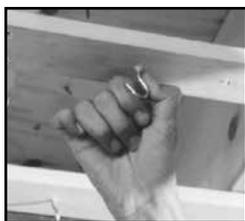
1. Installez les crochets de fixation sur la fourrure ou les solives de plancher.
