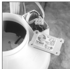
Câblage Romex - Vue de dessus.
