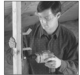
Fixer le support de montage (MB).
